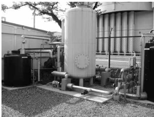
本部キャンパス北側に設置された専用水道システム
