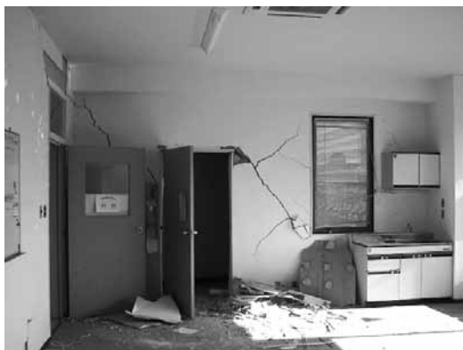
震災で室内の壁が崩れ落ちた
