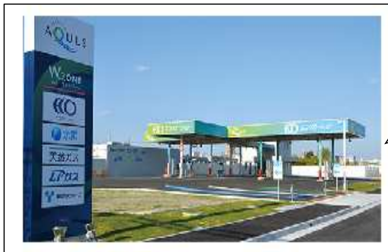
▲水素・天然ガス・LPガスの併設スタンド(東邦ガスHP)
