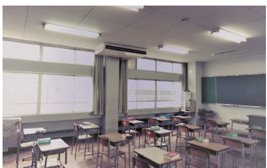
室内機は天井吊形5馬力を1基設置
