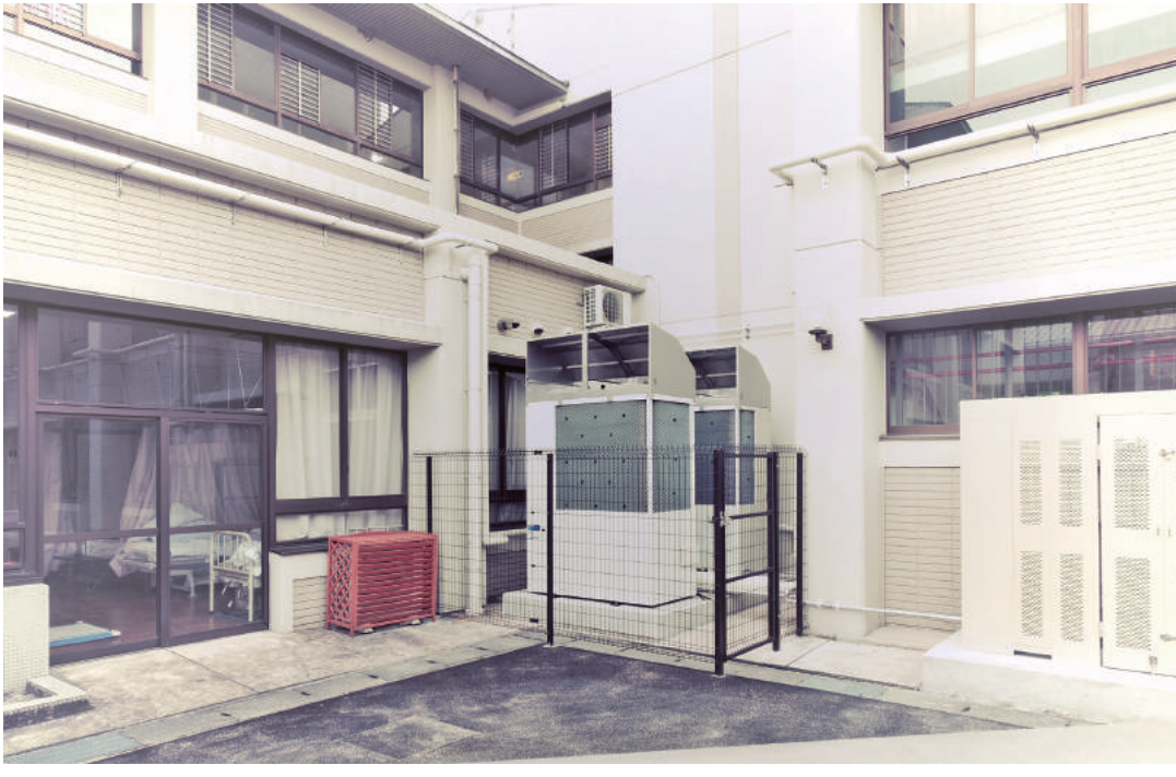
草津養護学校でも配管などを考慮して、最適な場所にGHP、供給機器を設置した
