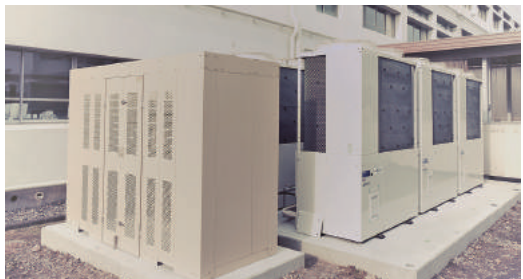
栗東高校に設置された室外機。分散設置し、供給設備も室外機に近いところに置いた
