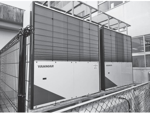
竜丘小学校に設置した30馬力LPガスGHP「エグゼア」室外機2台
