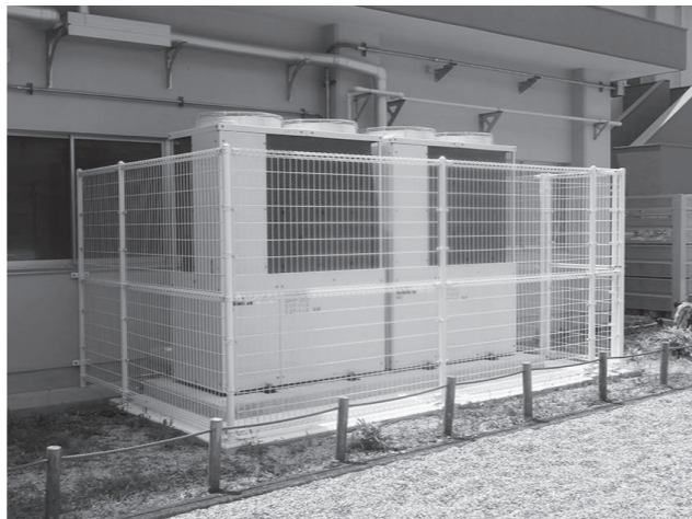
奥殿小学校に設置されたGHP
