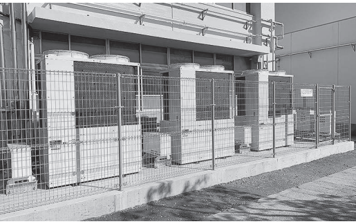
桔梗が丘中学校に設置したGHP
