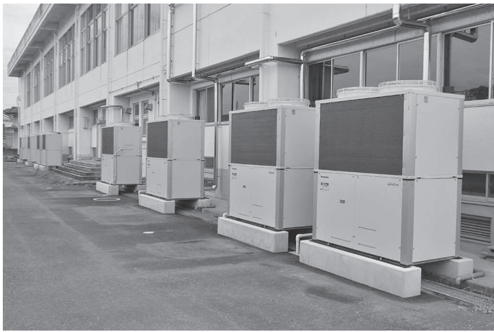
大間々東中学校体育館に設置されたGHP 8台
